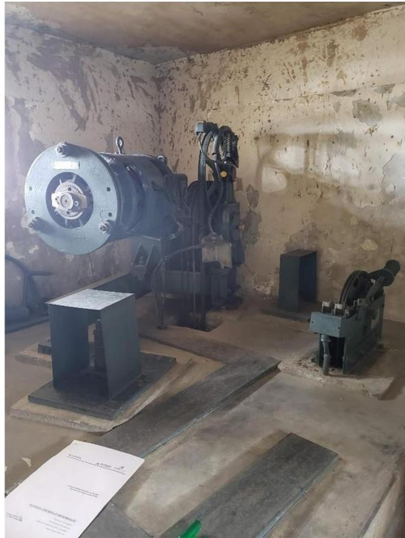
Foto 5 – Máquina de tração e motor freio
